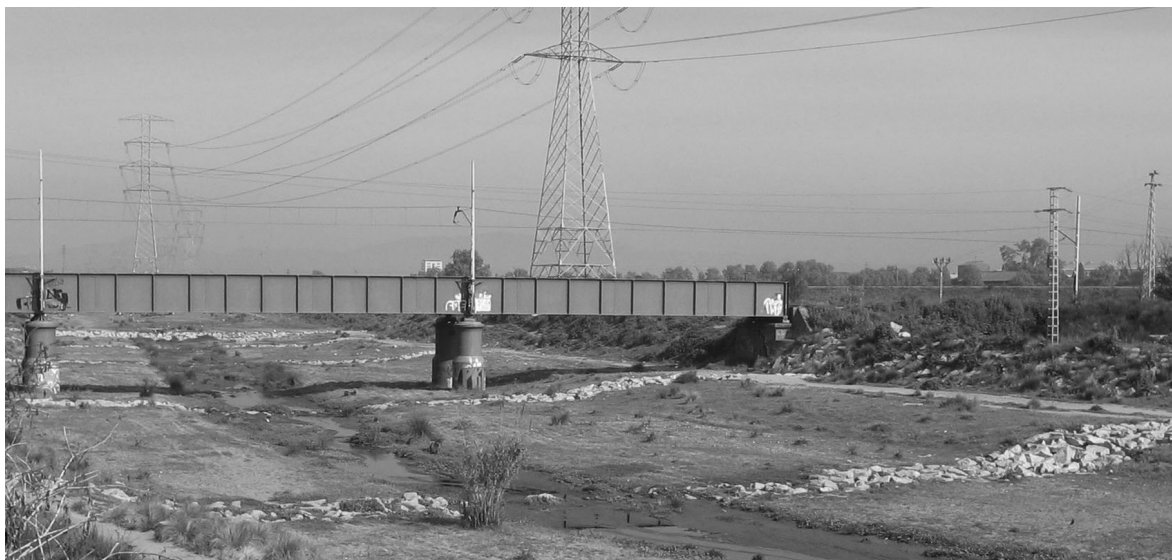
Figura 1. Traviesas de escollera en el lecho de un río efímero (riera de Caldes, Barcelona, España).
