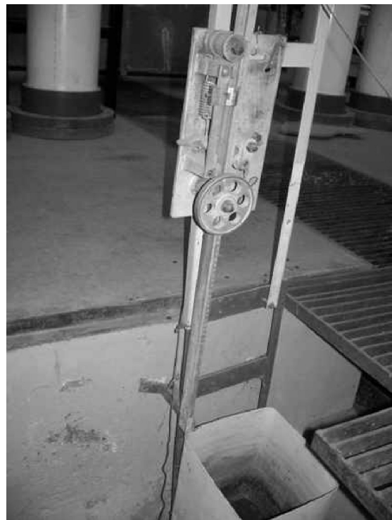
Figura 3. Limnómetro para leer la carga sobre el vertedor Rehbock.
