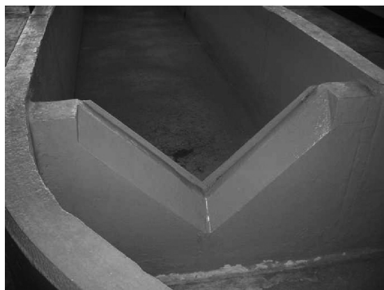
Figura 8. Vertedor triangular.
