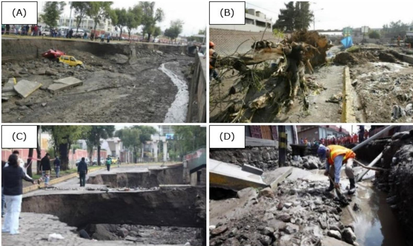
**Figura 5.** Aluvión registrado el 8 de febrero de 2013 en la ciudad de Arequipa: A) y B) calles invadidas de lodo por activación de quebradas posteriormente torreteras; C) y D) vías destruidas como consecuencias de las inundaciones por acción de la intensa lluvia registrada. Fuente: Diario Correo (2014).
