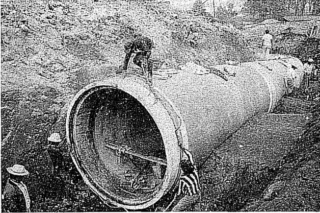
1. Tuberías de concreto reforzado de 99" de diámetro
