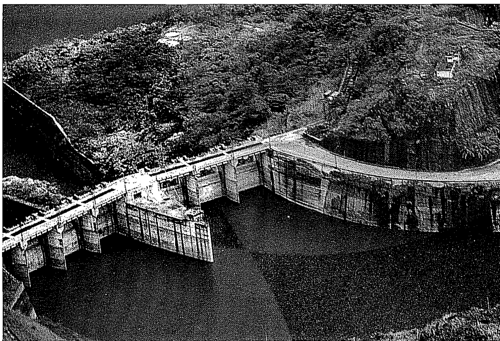
Presa hidroeléctrica Malpaso, Chis.
