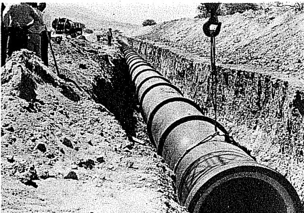
Instalación de tubería de concreto de 2.10 m de diámetro
