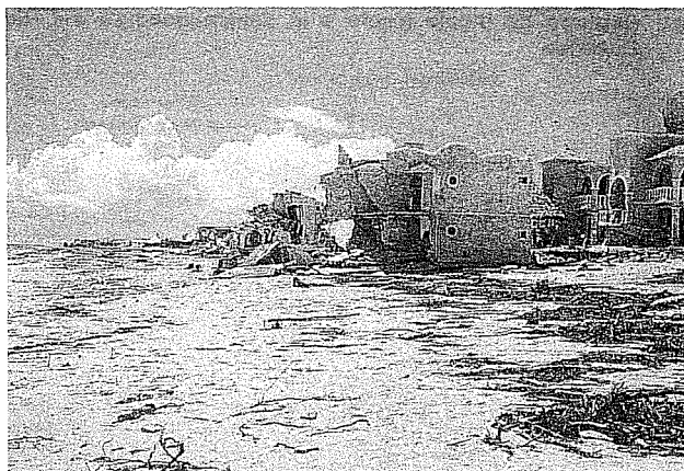
29. Contraste entre daños a la primera y segunda líneas de edificaciones (Puerto Morelos, Q.R.)
