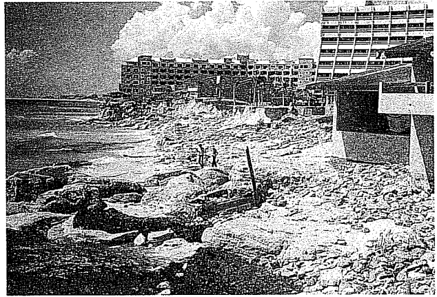
32. Erosión del material granular en la zona hotelera de Cancún
