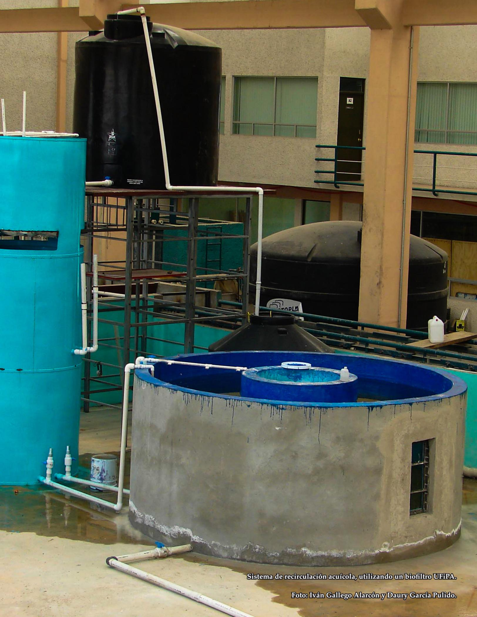
Sistema de recirculación acuícola, utilizando un biofiltro UFiPA.
